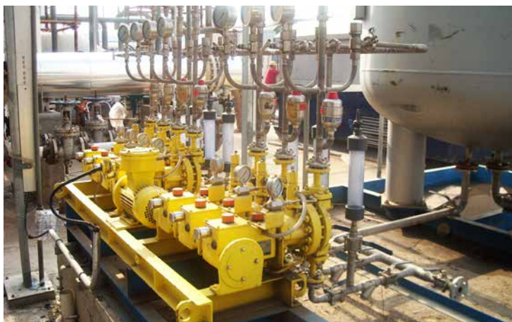
◀ 石化：缓蚀剂注入泵
